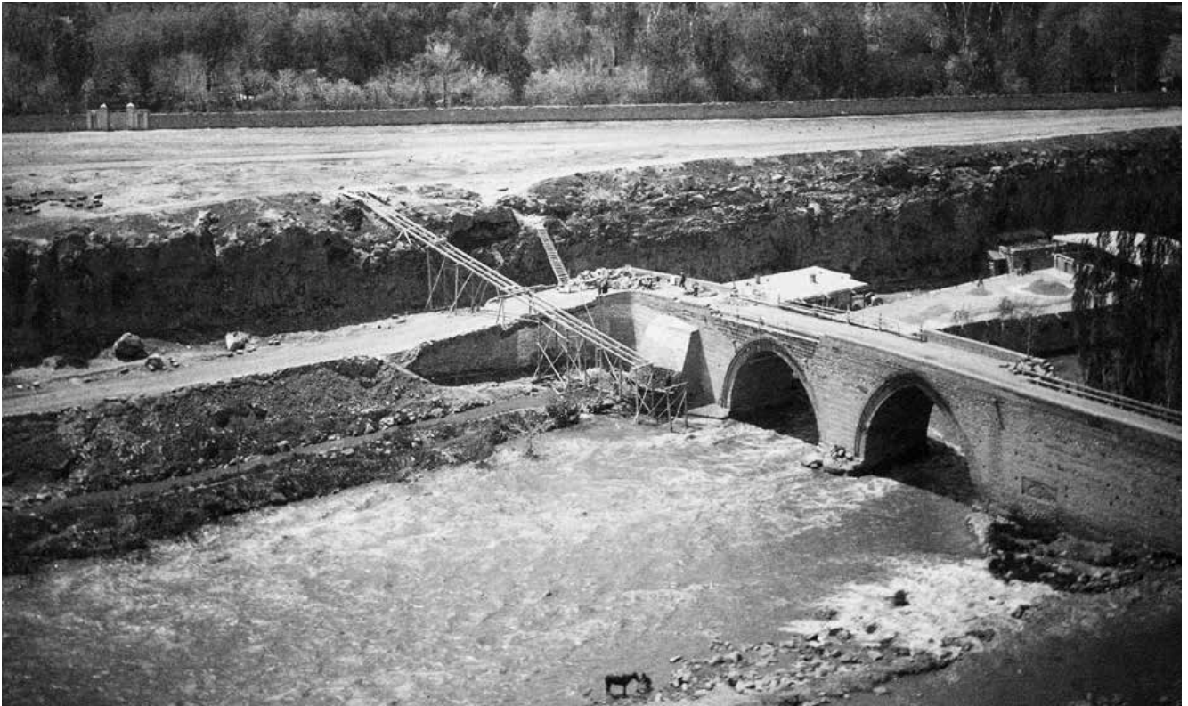
Vue générale du pont sur la rivière Zangui et du jardin de Sardar, Irevan.
