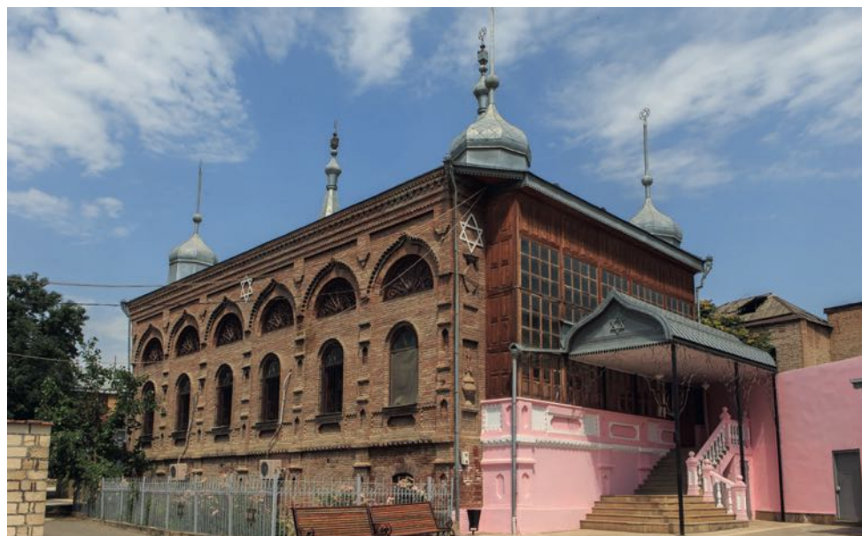
Sinagoga de 6 cúpulas en el pueblo de Girmizi gasabá cerca de la ciudad de Gubá
