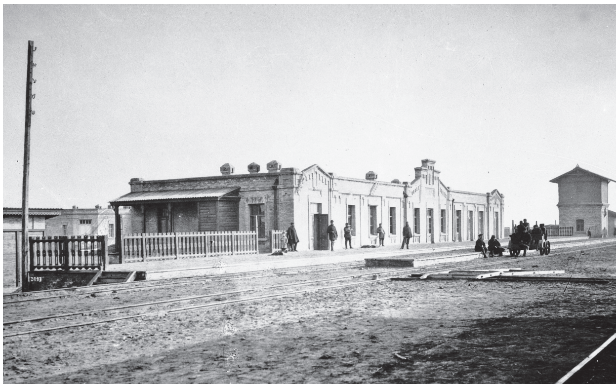
Станция Кюрдамир. 1916 год
